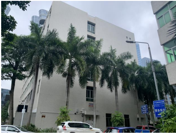
项目西南面工业厂房
