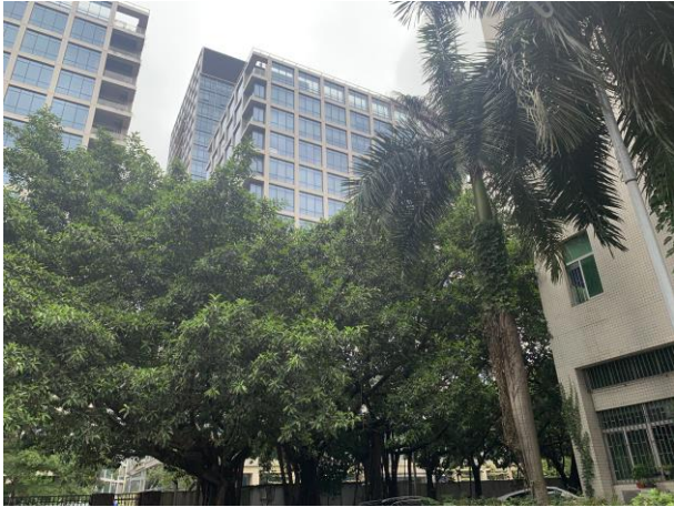
项目西北面办公楼
