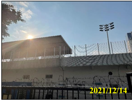
项目西面深圳第一技工学校
