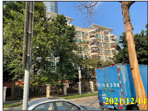
项目北面兰亭居
