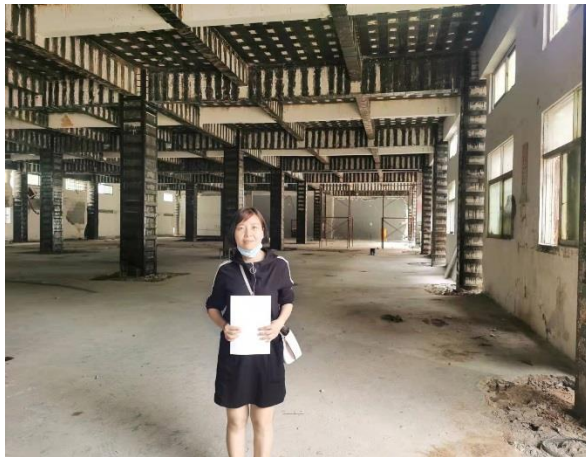
工程师现场勘察图片②
