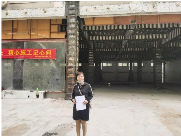
工程师现场勘察图片①
