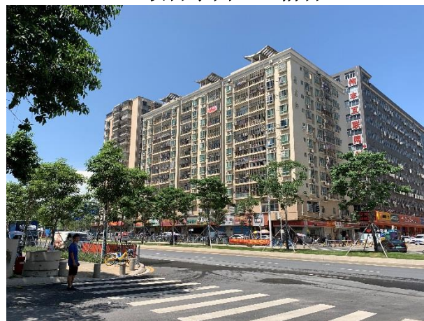
项目西面居民楼
