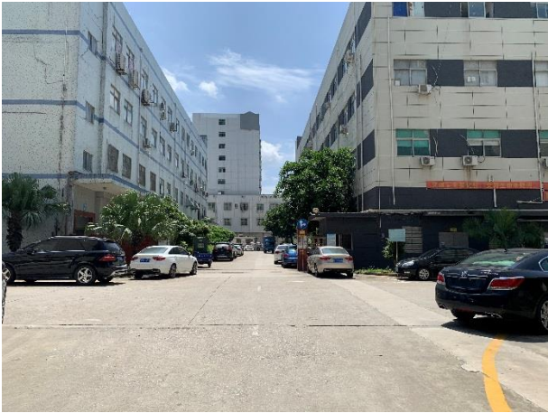
项目厂房外观
