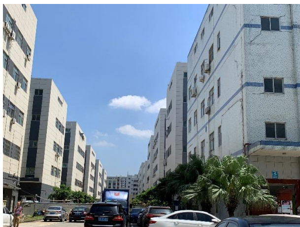
项目北面工业厂房
