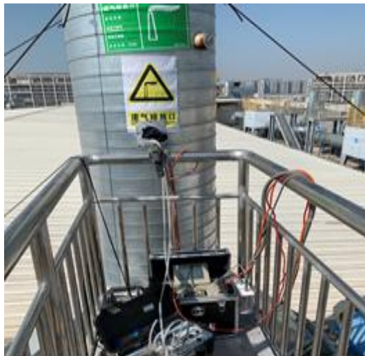
项目废气排放口标识
