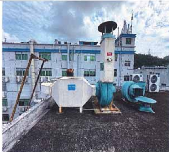
本次验收的有机废气处理设施2#及DA003排气筒
