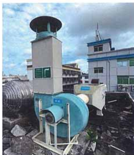
已验收的有机废气处理设施1#及DA001排气筒
